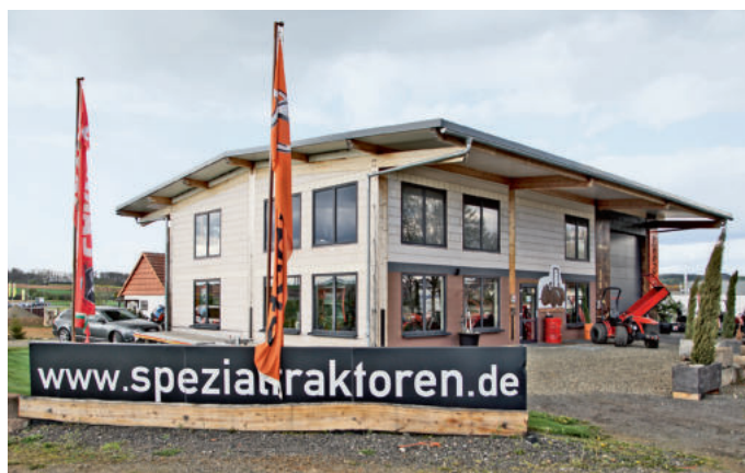
Das neue Gebäude wurde 2016 errichtet und beherbergt Werkstatt, Ausstellungsraum, Büro und Ersatzteillager.
